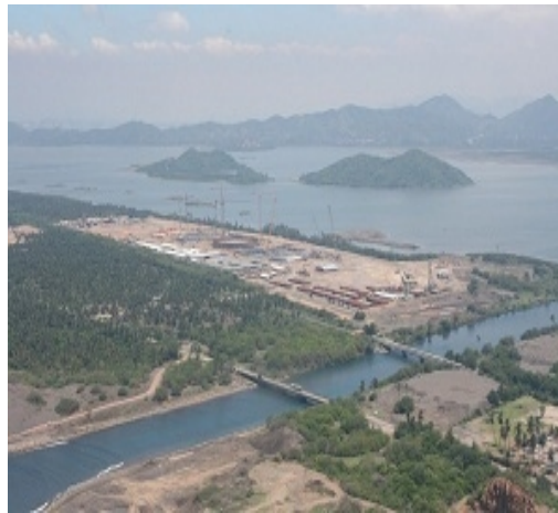
Figura 4. A la izquierda, la Terminal de Gas Natural Licuado Manzanillo en proceso de construcción (110ha).
