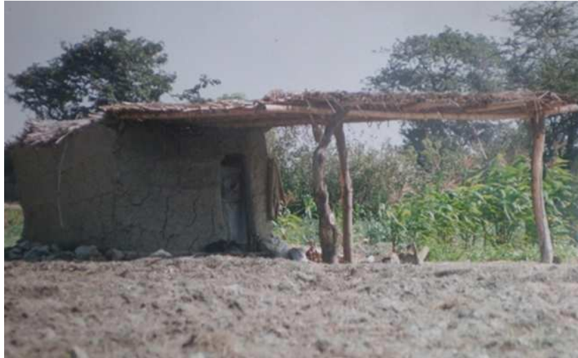
Figura 25. Vivienda rural contemporánea con base de piedra y ramada (campiña de Paiján, valle de Chicama).
